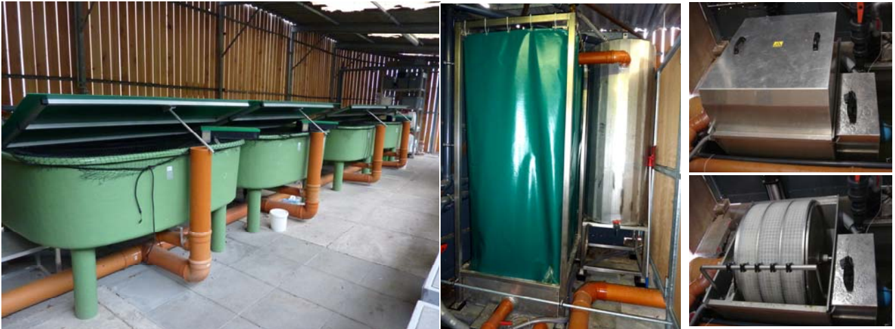
Obere Reihe: Links: neue Becken; Mitte: Biofilter aus Chromstahl und Entgasungsturm; Rechts oben: Trommelfilter zugedeckt; Rechts unten: Trommelfilter ohne Abdeckung Untere Reihe: Versuchsaquarienanlage
